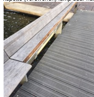
deel houten bank afgebroken
