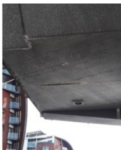
Ad 4. plafond toegang parkeergarage
