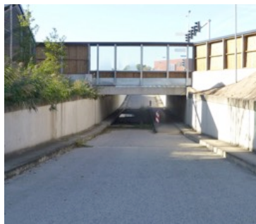
Tunneltje onder Ringweg
