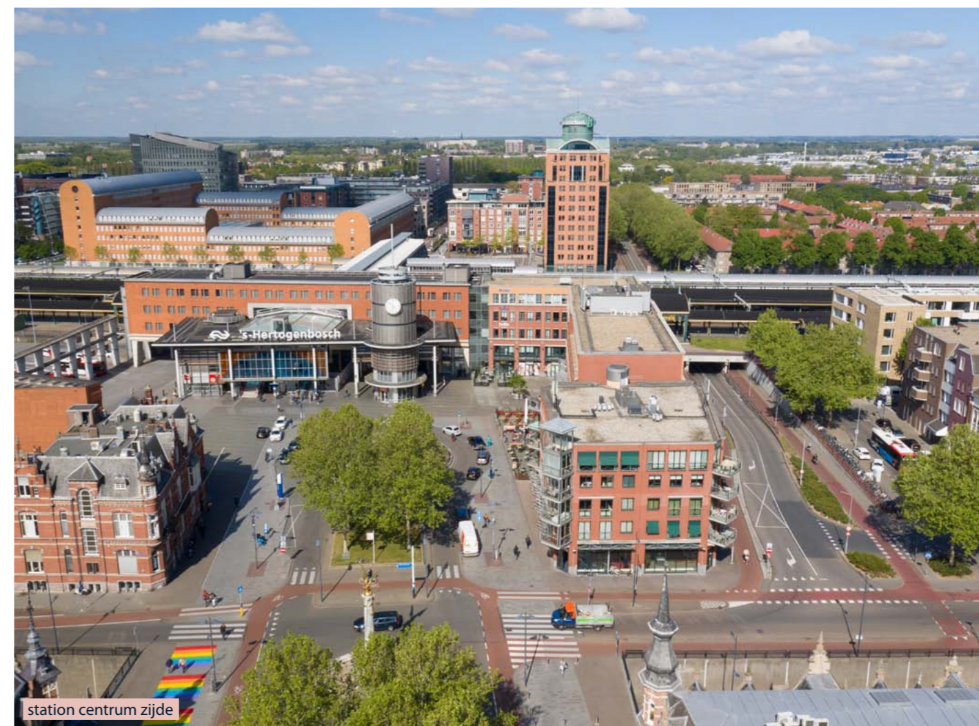
westelijke entree station
